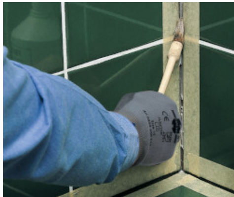
Application of Primer FD
